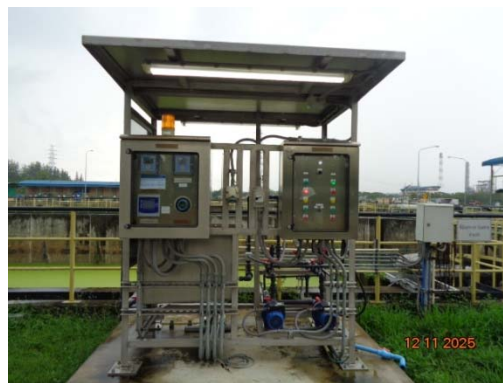
รูปที่ 16 ระบบตรวจวัดน้ำทิ้งแบบอัตโนมัติ
