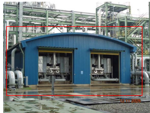
รูปที่ 10 วัสดุปิดครอบแหล่งกำเนิดที่มีเสียงดัง
